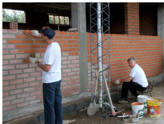
Foto: Henry und „Kollege“ am Bau
