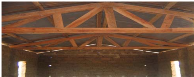
Die nahezu fertige Kapelle ist fest gerüstet
